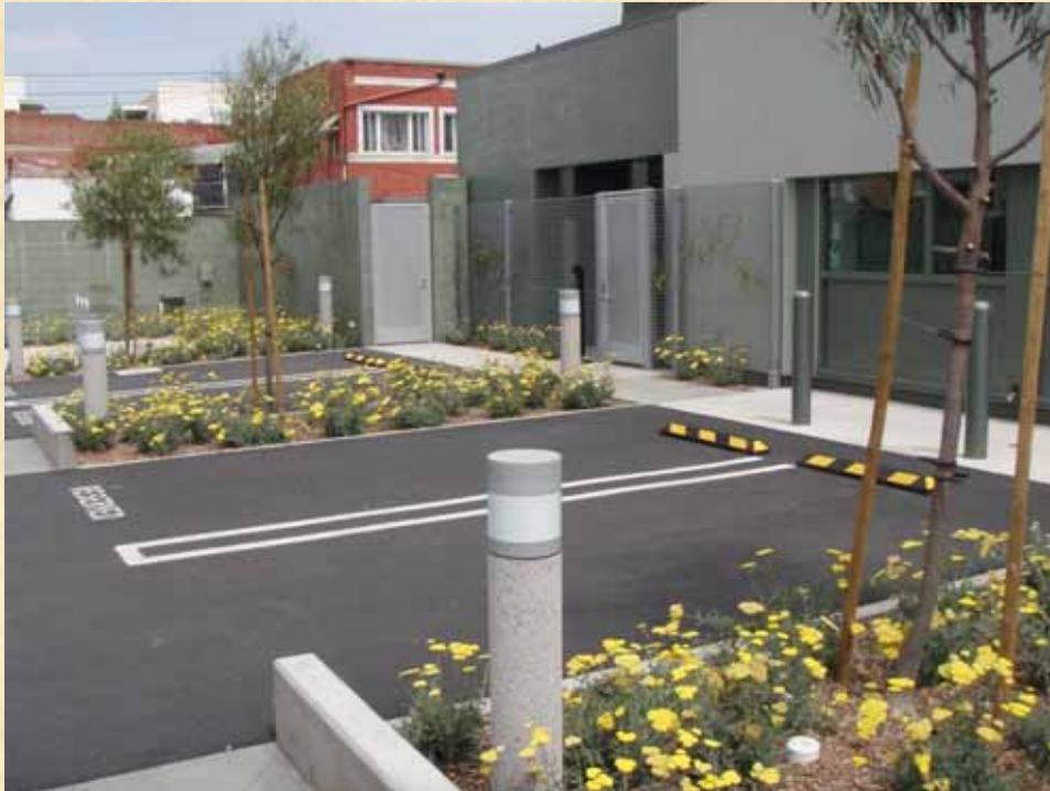
Simple bioswale edge
